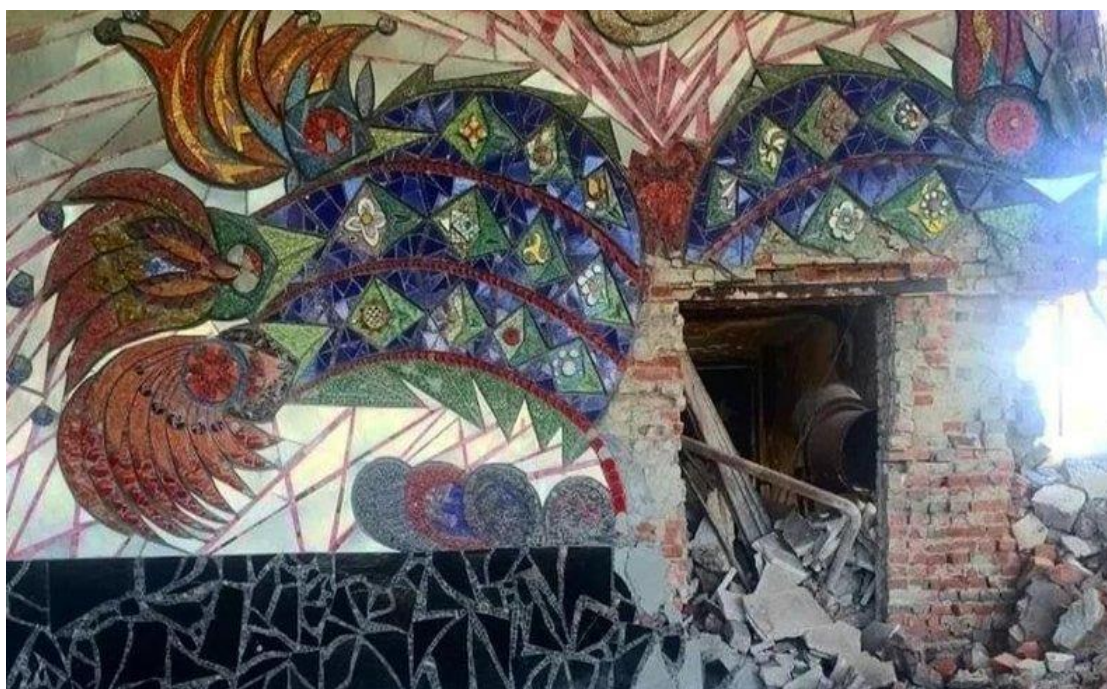
Зруйнована мозаїчна композиція «Дерево життя»
